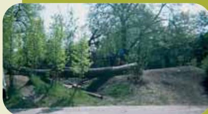
Stoßdämpfender Untergrund unter „Brücke“ mangelhaft (Baumstämme)
