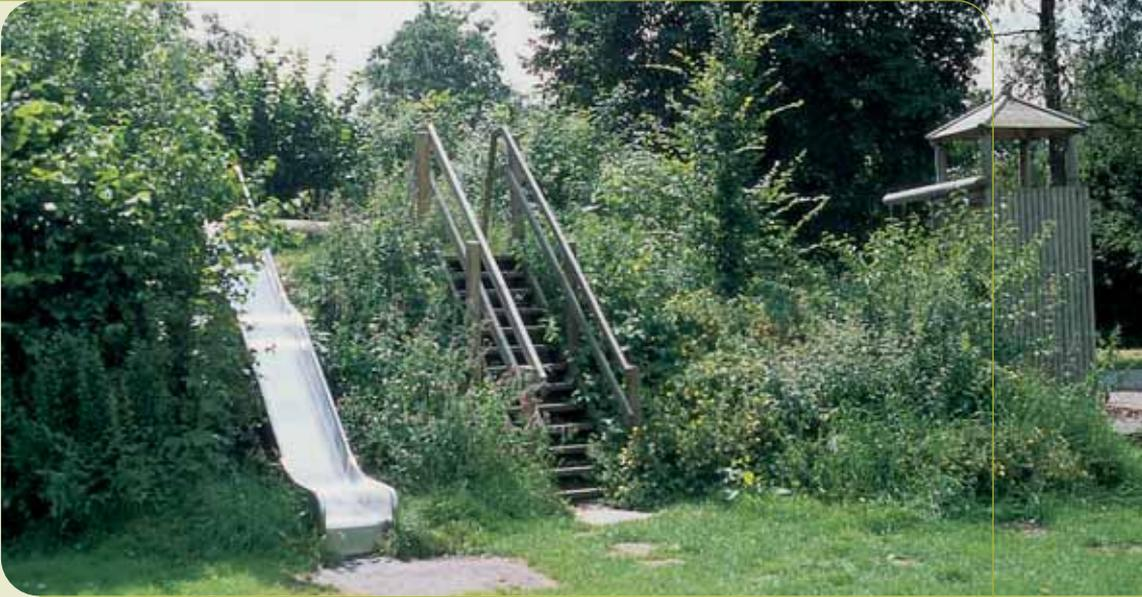
Ausreichend befestigte Rutsche (DIN 7926/EN 1176), ungeeigneter Auslaufbereich
