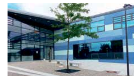
Abbildung 43: Neues Campusgebäude am Teilstandort Käthe-Kollwitz-Straße (nach: Million, A. et. al. Gebaute Bildungslandschaften. Berlin: Jovis Verlag, 2017, S. 149)
