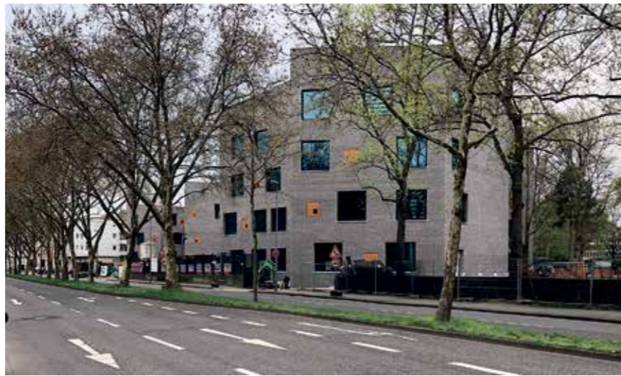
Abbildung 59: 1. Bauabschnitt (Planung und Foto: gernot schulz : architektur GmbH im Auftrag der Stadt Köln)
