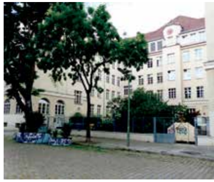
Abbildung 52: Bestehendes Gebäude der Gemeinschaftsschule (Foto: A. J. Heinrich in: Million, A. et. al. Gebaute Bildungslandschaften. Berlin: Jovis Verlag, 2017, S. 125)
